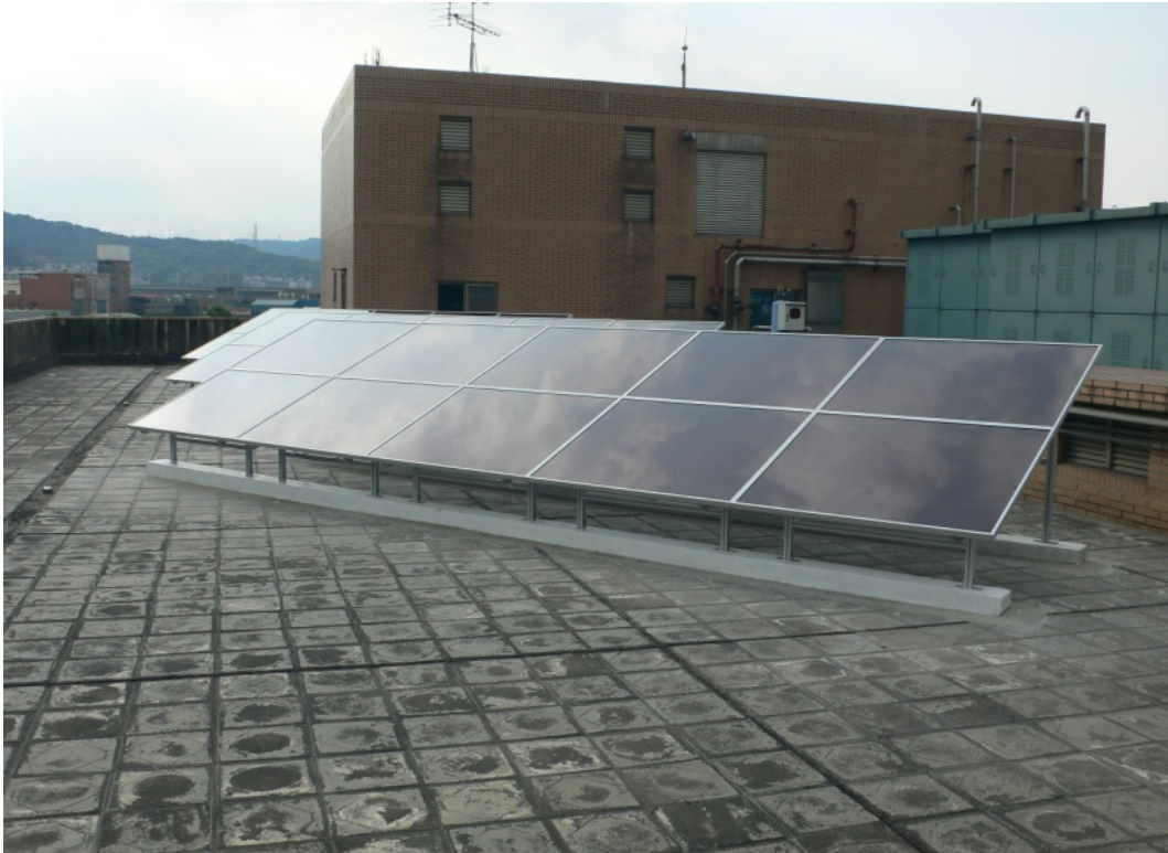
薄膜型 3kWp 太陽光電示範系統 (p. 48)
