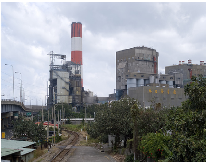
圖1、台灣電力公司林口發電廠
