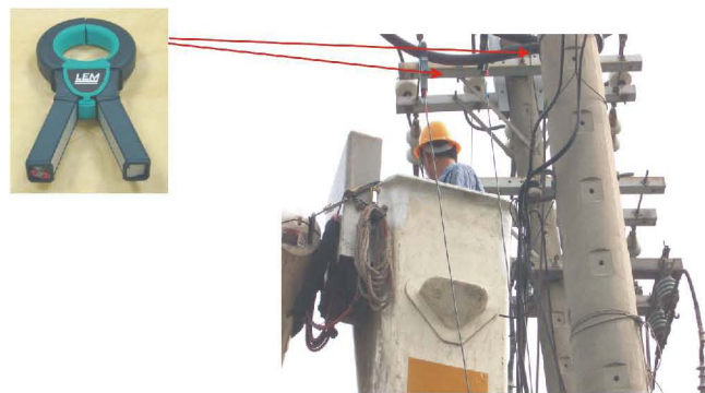
圖3 相別量測作業將勾錶勾掛於待測相別電纜上
